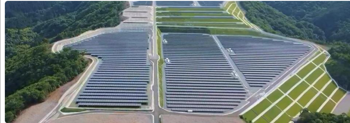
大型太陽光発電所施工事例
